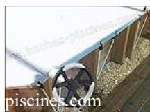
**Sangles de maintien** sur les largeurs avec cliquets de tension tous les 1.40 m maximum et tension avec œillet et sandowsclics centrés entre les tubes et de chaque côté des tubes d'extrémité (quand pan coupé). Margelle 20 cm minimum. **Piscine semi enterrée** avec hauteur des margelles par rapport au sol d'au moins 60 cm
